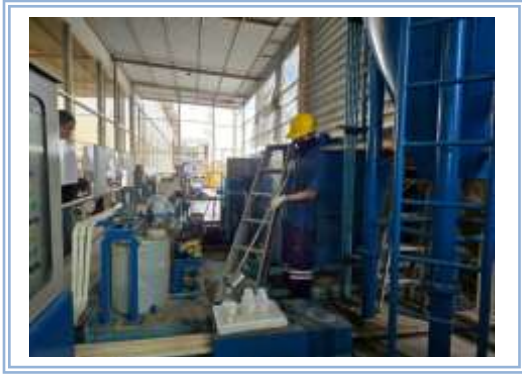
น้ำเสียเข้าระบบบำบัด
