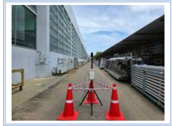
บริเวณ Insulation/Aluminum Panel/Glass Storage Zone
