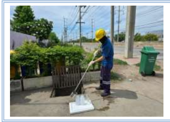
น้ำทิ้งหน้าโรงงาน
